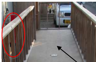
(写真2) 消火器の設置場所
