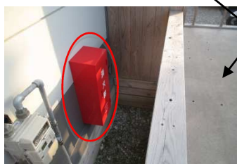
(写真3) 消火器の設置場所
